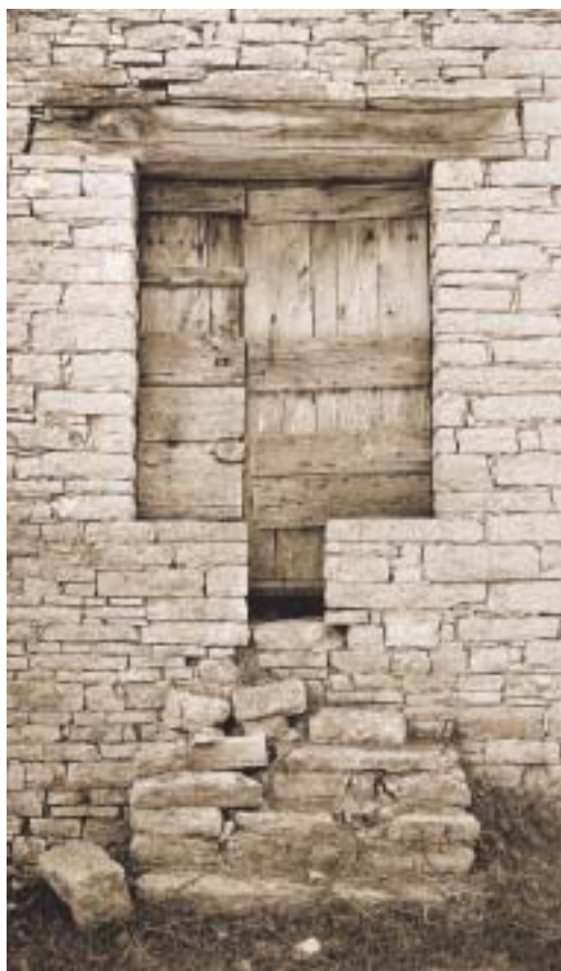
Porta d'ingresso al fienile di una stalla
