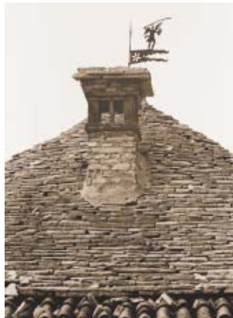
Copertura in piöde. Contrada Cà Prospero di Locatello
