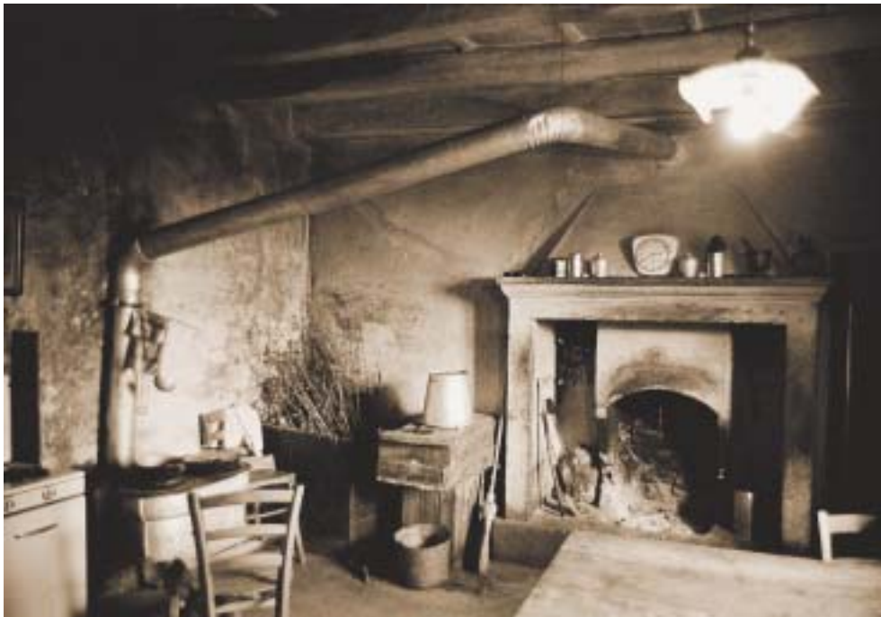
Il locale del camino. Contrada Regorda di Coma Imagna
